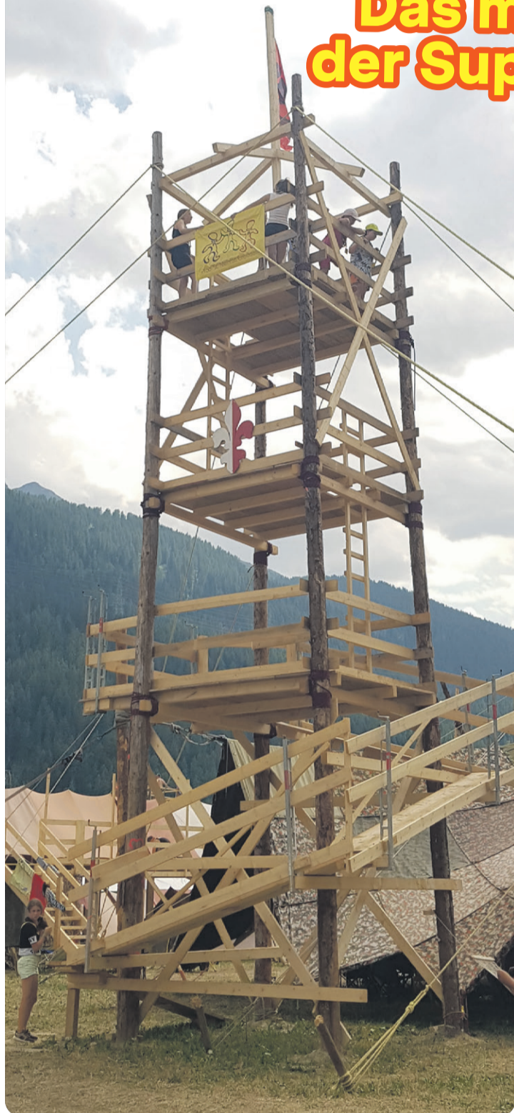
Beim höchsten Lagerbau holt sich die Pfadi Einsiedeln die Lorbeeren: Bis zu 20 Leute haben in eineinhalb Tagen einen zwölf Meter hohen Turm aufgestellt. Auf drei Etagen bewundert man hier die Aussicht über die Kontinente Oscilla, Eniti und Salit.
